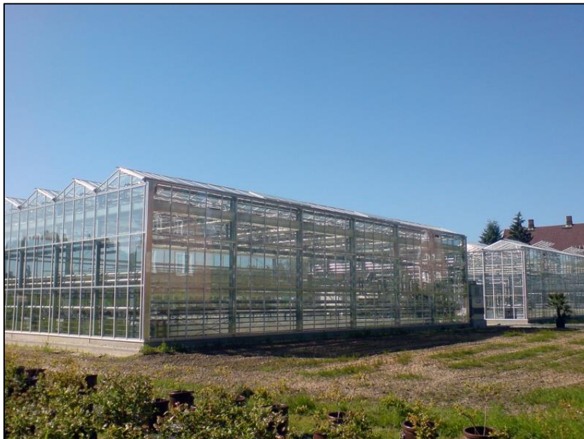
Blick auf das Kollektor- (vorne) und Referenzgewächshaus (hinten)
