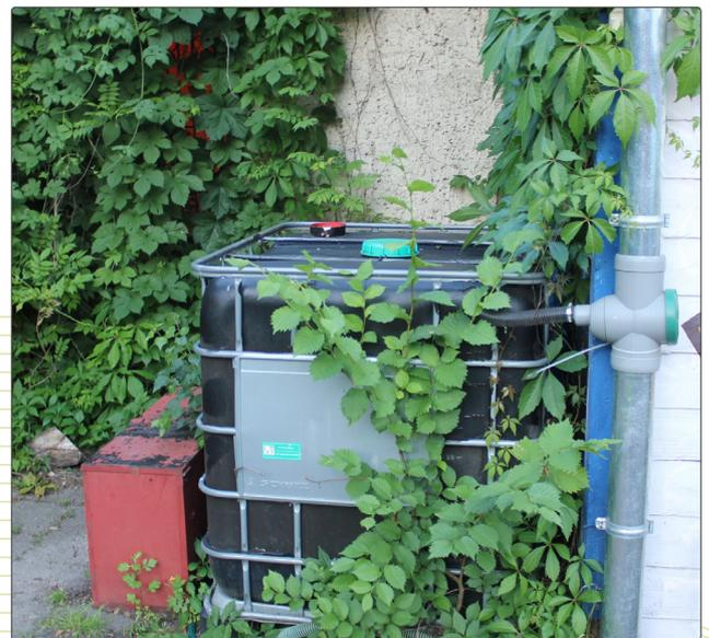
**Abbildung 3** Eine Regenwasserauffangananlage für eine trink- und grundwasserschonende Bewässerung
