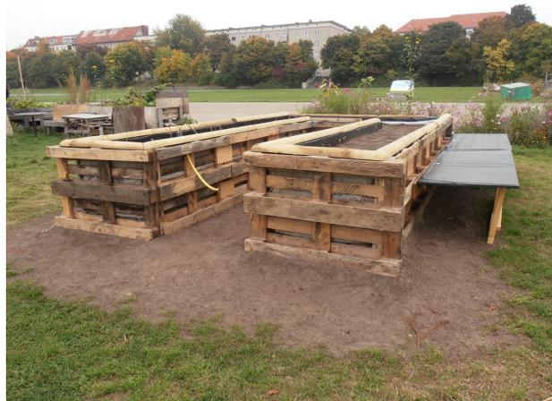
**Hochbeet aus „Recyclingmaterialien“ mit ausklappbaren Flügeln fängt Regenwasser auf, leitet es zu einem innenliegenden Wasserspeicher, der das Wasser über Dochte (ggf. Pumpe) der darüber liegenden Vegetationsschicht zur Verfügung stellt!**
