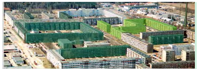
Zurückgebaute Gebäude Böhmischer Ring Zurückgebaute Gebäude angrenzendes Wohngebiet
